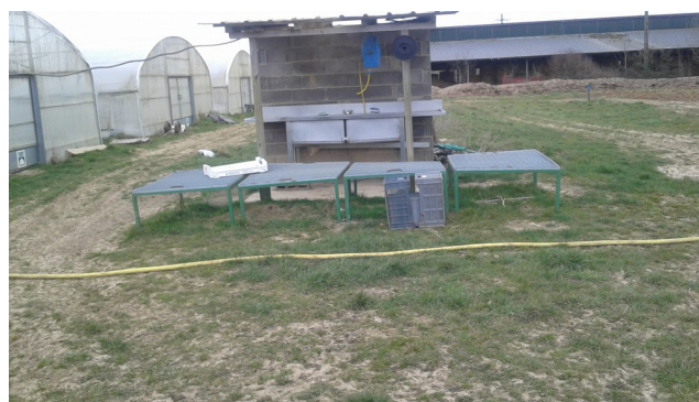
A gauche, les serres, à droite une parcelle maraîchage plein champ, au centre la station de pompage pour l’irrigation et la zone de lavage des outils et légumes
